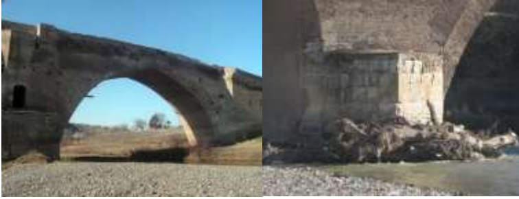
Şəkil 2. Körpünün ən iri ölçülü dalğaqranı.
