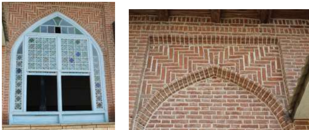
Рисунок 4. Мечеть в селении Ашагы Ньюяди. Фрагменты фасада. Арочное окно. Кирпичная кладка.
