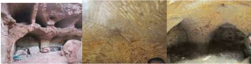
Şəkil 7. Qorb karvansarasının iç tağları və örtük kərpic düzüümü.
